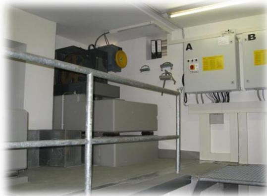
Die beste Anordnung des Triebwerkraumes für Seilaufzüge ist oben über dem Schacht. Er kann jedoch auch neben oder hinter dem Schacht angeordnet werden. Der Treibscheibenantrieb ist mit einer Frequenzregelung ausgerüstet, die eine komfortable Aufzugsfahrt bei hoher, lastunabhängiger Einfahrgenauigkeit in den Etagen gewährleistet.
